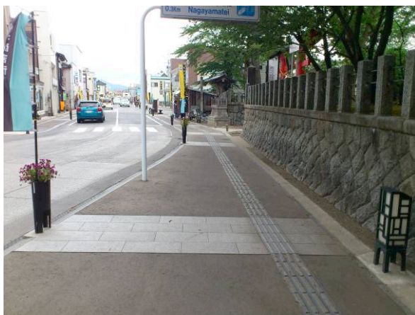
拡幅された歩道部分には、幟立て兼花台や行灯照明などが機能的にデザインされている。
