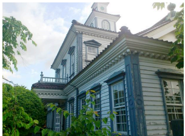
明治初期のルネサンス風建築・旧西田川郡役所
