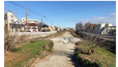
写真-1 瀬切れの状況 (2020/1/2 秋津南橋 下流側)
