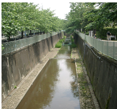
写真-1 佃橋水位観測所付近の状況
