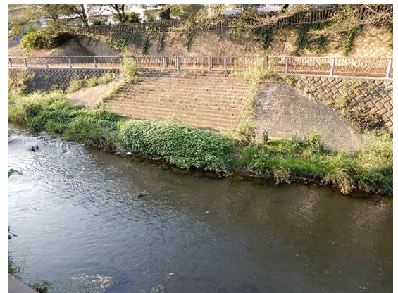
図-5 南田中護岸の緩傾斜部分
