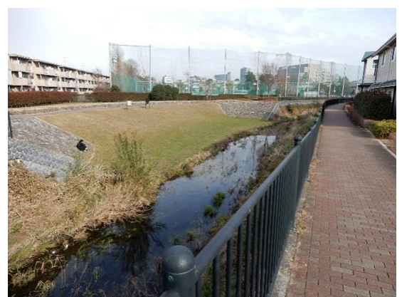
図-6 東伏見護岸の緩傾斜部分
