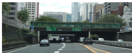
写真-1 築地川を河床干拓した首都高 (筆者)
