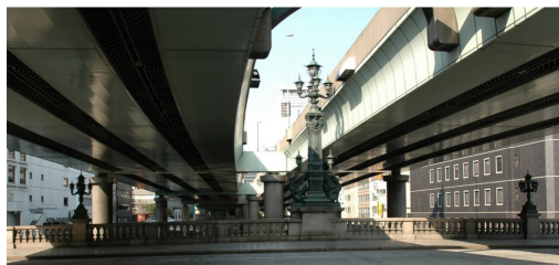
写真-2 日本橋(川)を覆う首都高の低い桁下空間
