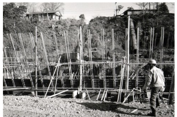
図-5 大滝（施工中） 10)
