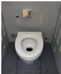
図-3 洗浄水循環型尿分離大便器
