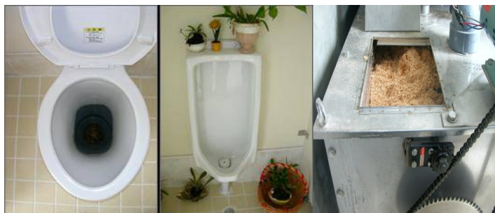
図-3 コンポスト型トイレと処理槽
