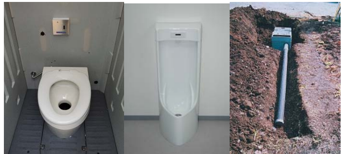
図-1 洗浄水循環型トイレと処理槽 (覆土前)
