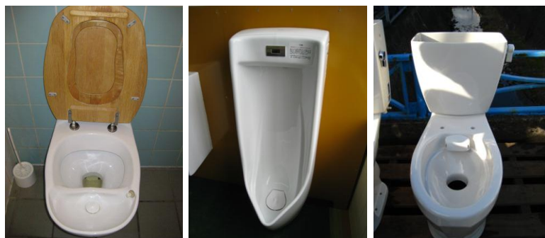
図-1 尿分離型トイレの例 図-2 男子用無水小便器の例 図-3 洗浄水循環型トイレの例
