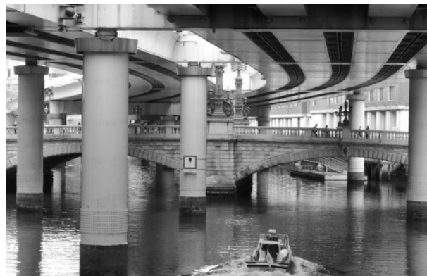
図-1 日本橋川・日本橋橋梁と上空を縦断占用する桁高が低く橋脚の林立する首都高(著者撮影)
