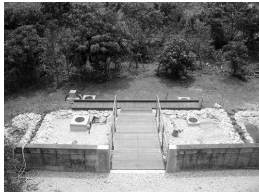
写真-1 本雑排水処理システムの人工湿地 （2004.5完成直後）
