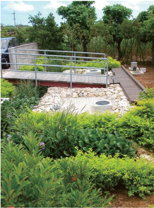
写真-2 本雑排水処理システム (2004.12) Photo 2 Gray water treatment system (2004.12).
