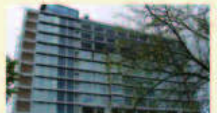
①・② 高層階層専用高齢者住宅への改修(オランダ)
