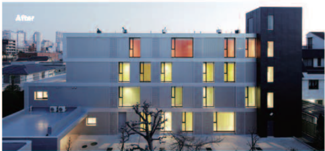
高層階は外部廊下だったのが（写真下）、それを内廊下として取り直し、高かい歩道橋をつくりだした
