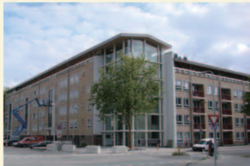
⑧ Dredkirkhof (オランダ)
