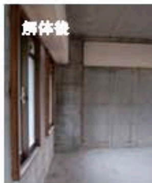
ロタイプ全館土間解体時
