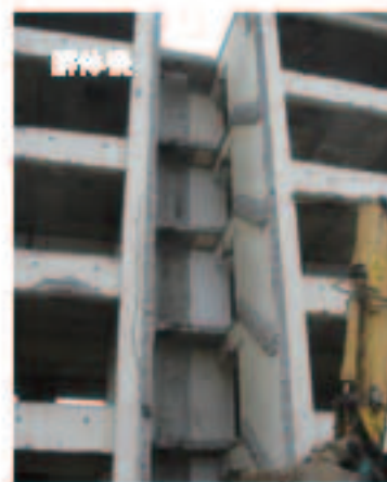
階段スラブの増築
