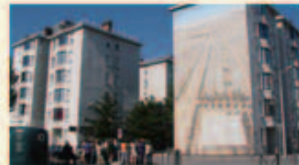
③ トニー・ゴルニエの建地の改修(フランス)
