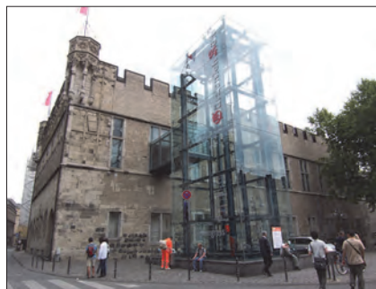
図3 ドイツ・ケルン会議場。古い建物にガラスのエレベーターが付き、すぐに「再生建築」と認識できる。
