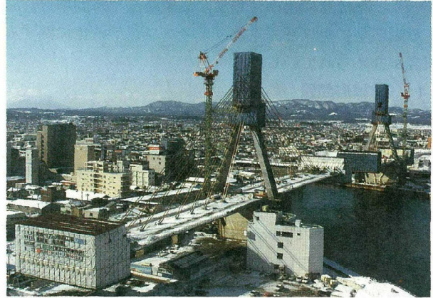
写真-2 青森ベイブリッジ (施工中)
