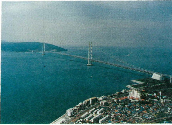
写真-3 明石海峡大橋 (本四公団提供)
