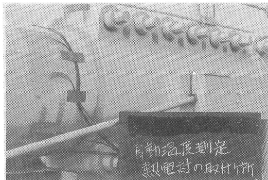
図.9 表面温度の測定状況
