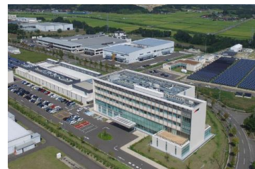
福島県再生可能エネルギー研究所
