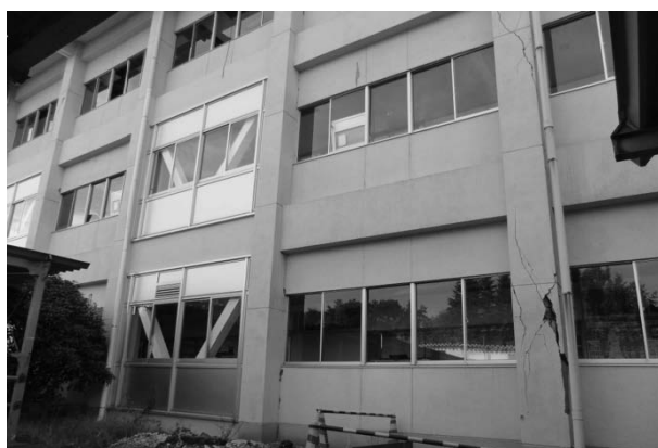
写真 4.2.4 C通りの鉄骨ブレースに隣接し C-8 柱（右側）のせん断破壊
