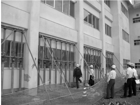
写真 4.2.12 せん断破壊した 3 本の RC 柱
