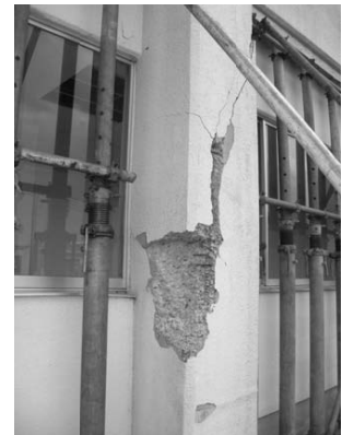
写真 4.2.13 1 階柱のせん断破壊
