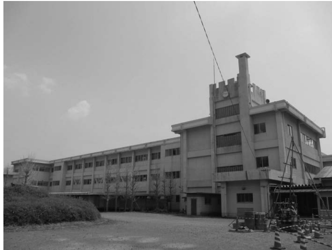
写真 4.2.1 普通教室棟 北側全景
