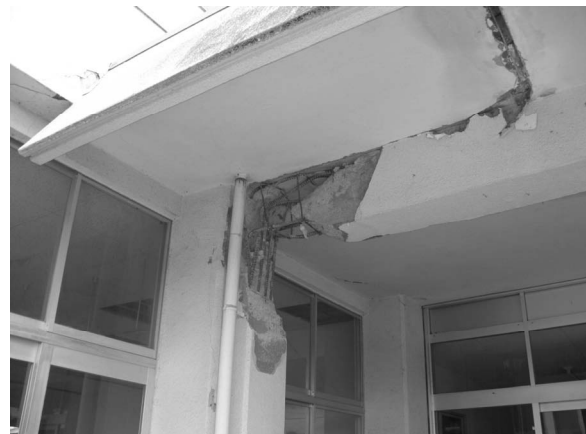
(a) 管理棟(左)、教室棟(右)と昇降口の庇 (b) 教室棟の昇降口の底を支える梁の損傷
