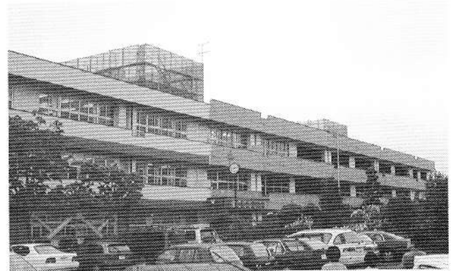
写真10 米山中学校・教室棟（手前が耐震改修済みの西側、奥が未改修の東側）
