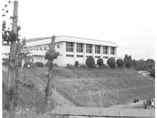
写真2 金成中学校・体育館の全景
