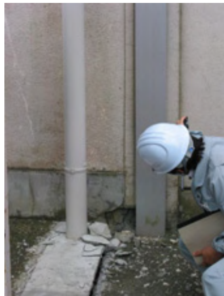
写真3.4 Exp.J. 部分の段差（約8cm）
