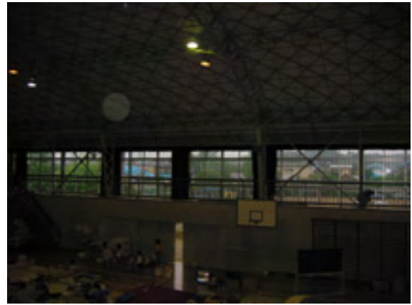
写真5.6 体育館二階の鉄骨ブレース（2枚）
