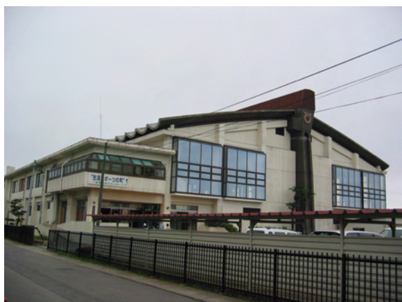
写真4.1 矢本町民体育館 全景
