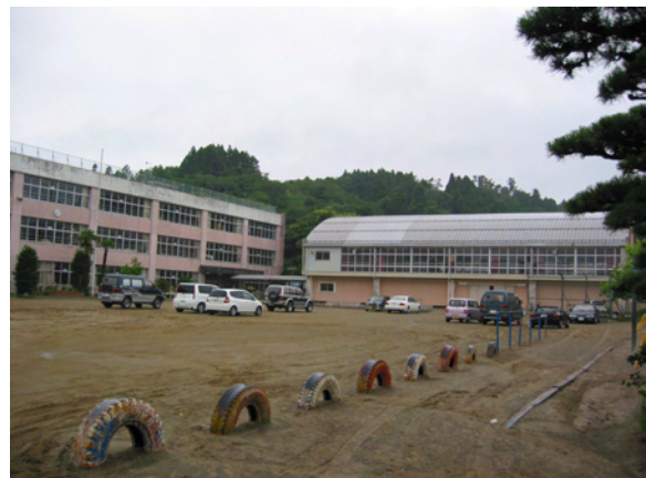
写真5.4 体育館 全景（左手は校舎）
