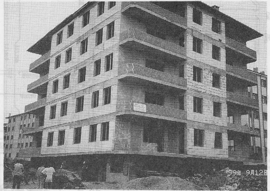
写真9 調査した6階建て鉄筋コンクリート建物の全景
