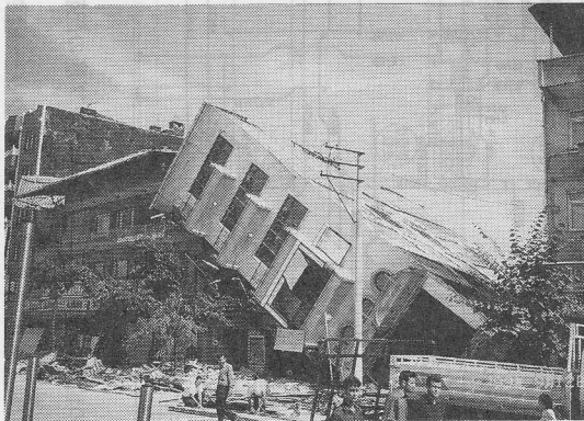
写真8 アダパザル市内の建物の転倒
