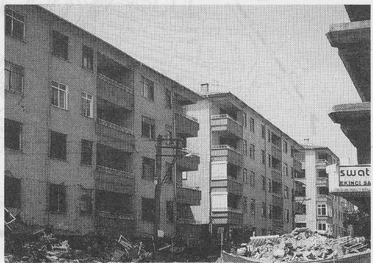
[ほぼ同一形状の建物3棟のうち、一番手前は2層分崩壊し、次は1層分崩壊したのに対して、一番向こうの建物は崩壊を免れた]
