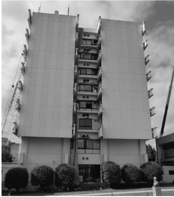
付写真Ⅱ.2-4 D・0棟の全景
