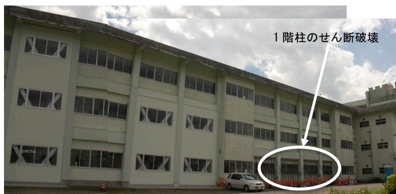
付写真Ⅱ.2-10 校舎の北側構面
