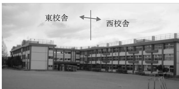
付写真Ⅱ.2-1 校舎の全景（左が東校舎、右が西校舎）
