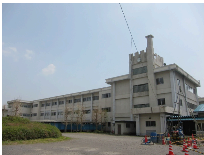
付写真Ⅱ.2-6 校舎の全景
