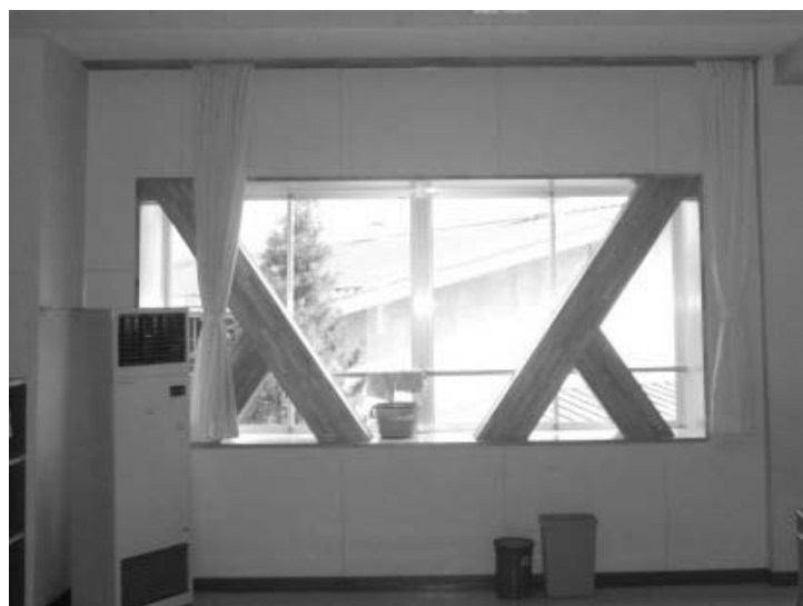
付写真Ⅱ.2-2 東校舎 1 階および 2 階の鉄骨ブレース補強
