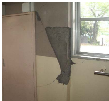
写真-3 T小学校1階雑壁
