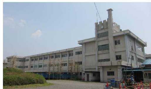
写真-1 普通教室棟 北側立面全景
