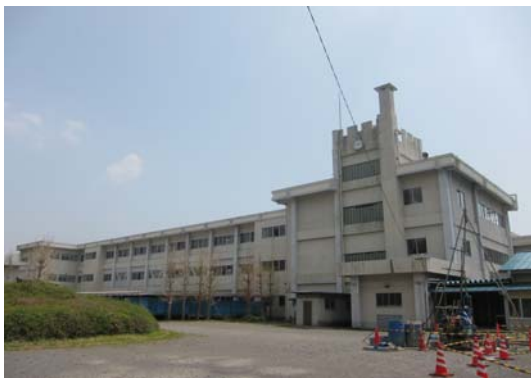
写真-1 普通教室棟 北側全景
