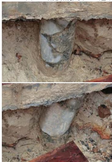
写真-3 D-18杭(上: 左杭, 下: 右杭)
