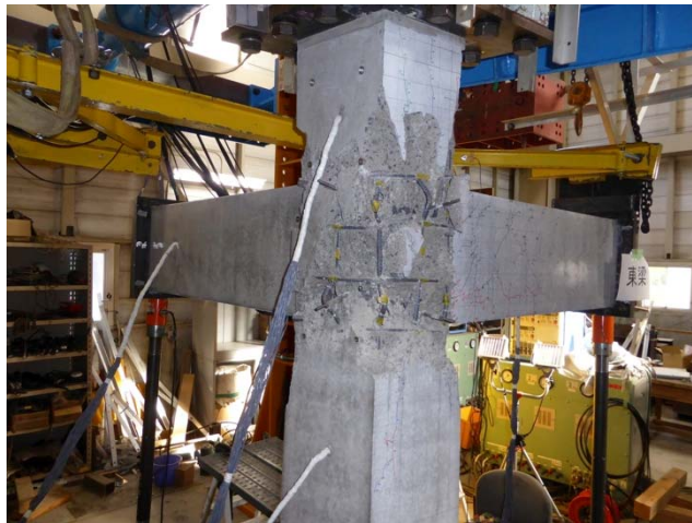
写真 4.4.2.1 立体隅柱梁接合部の曲げ破壊 4.4.2.5)
