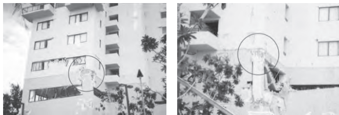
写真1 グラム地震 隅柱梁接合部の被害状況(栗栖浩一郎氏提供)
