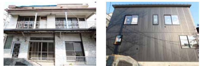
(a) 改修前 (b) 改修後 図1 対象建物外壁西面
