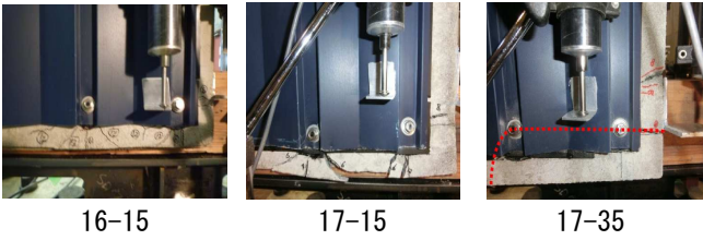
図3 モルタルの破壊の様子（変位 19 mm）
