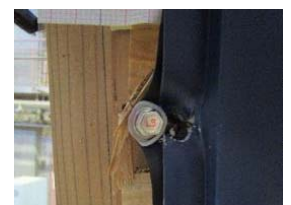
写真1 鋼板の端あき破断
