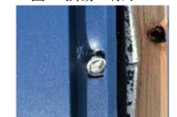
写真1 鋼板のパンチング
